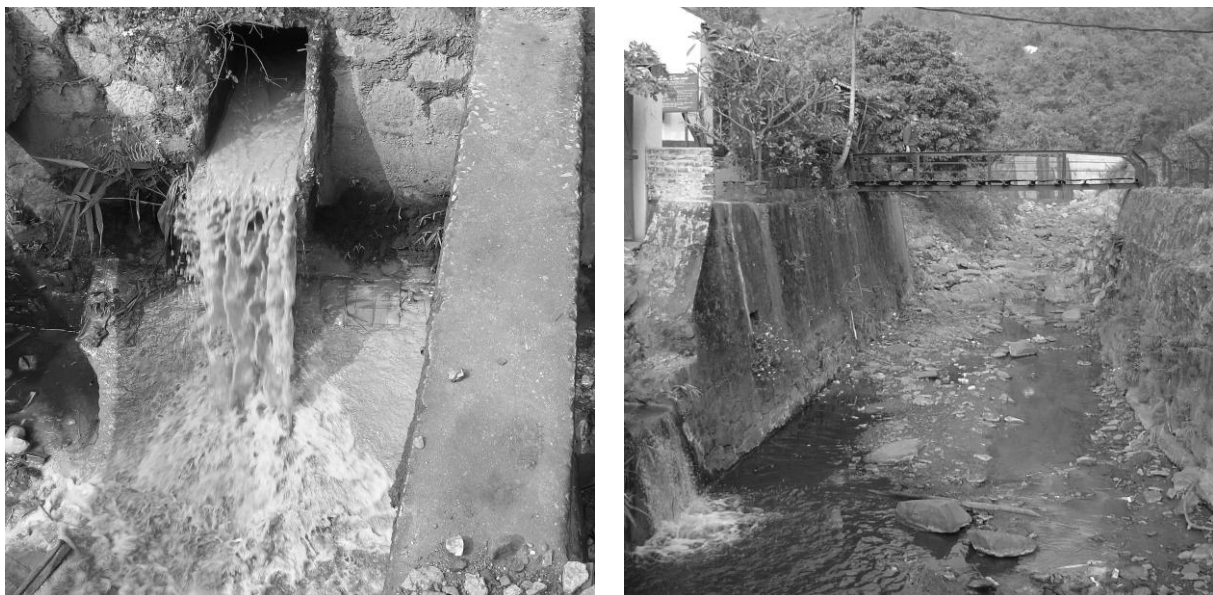
Abb. 2: Ableitung von trübem Grubenwasser des Stollens +122 tay in ein Gerinne (links) und die Einleitung des Stollens +122 dong in den Vorfluter (rechts; SCHLENSTEDT & DENKE, 2009)
